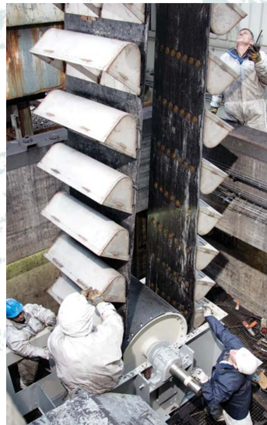
Unser Servicepersonal bei der Montage eines Gurtbecherwerkes. Our service personnel assembling a belt-type bucket elevator
